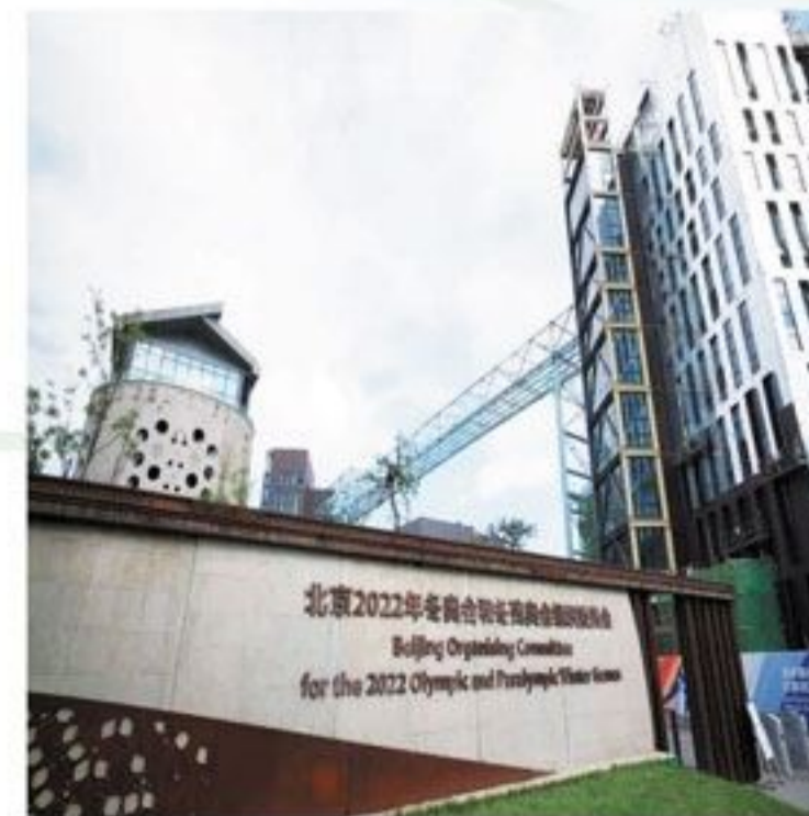
北京冬奥村（冬残奥村）接待中心
